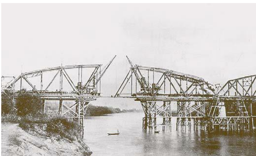
2. ábra: Az Összekötő vasúti híd építése; forrás: [6]
