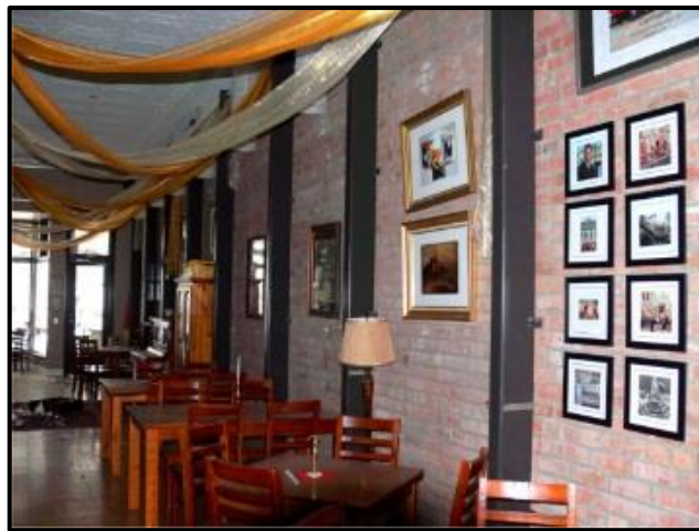
52. sz. ábra: Falazat belső megerősítése függőleges acél támaszokkal Forrás: [204; 76. o.] Készítette: nem ismert
