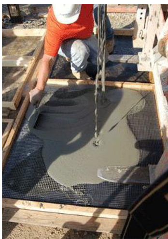
29. sz. ábra. Mikro-vasalatú beton elemek helyszíni öntése és beemelése (forrás: http://www.structuremag.org/article.aspx?articleID=600 2010.02.26.)
