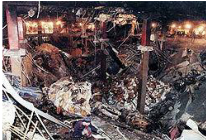
8. sz. ábra. World Trade Center garázsja az 1993-as robbantás után (forrás: http://www.nycop.com/Stories/Dec_00/World_Trade_Center_Bombing/body_world_trade_center_bombing.html 2011. 09. 11.)[59]
