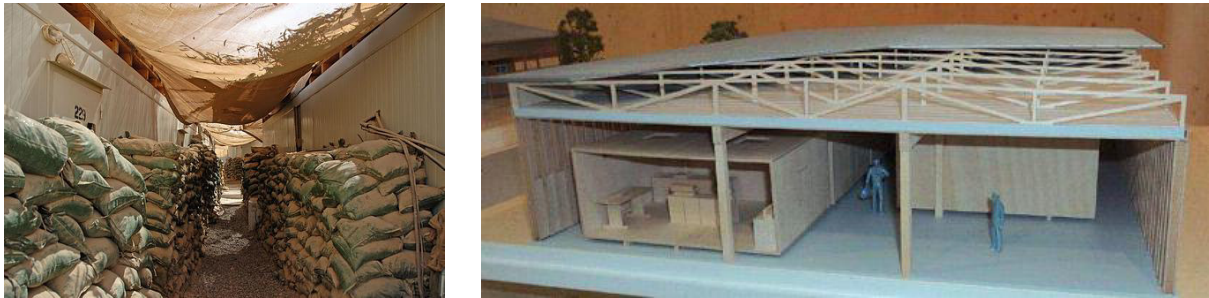
63. sz. ábra. Homokzsákos konténervédelem és a védőtető kialakítása 143 (forrás: Maj. Markus Scheid, MABS 2012 konferencián elhangzott előadásából –pen-drive-on)
