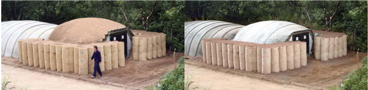
67. sz. ábra. Alagút formájú sátor földborítással és plusz vászonnal erősítve (forrás: http://www.concretecanvas.co.uk/Images/ccsgallery/index.html 2011. 09.17.)
