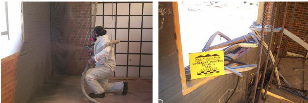
36. sz. ábra. Polimer réteg felhordása a falazatra és a teszt utáni állapot (forrás: http://www.linex.com/pages/2010/military/products/px_3350.php 2011. 05.05)
