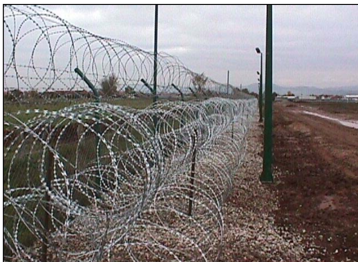
22. kép – Kerítés megerősítése drótakadállyal
