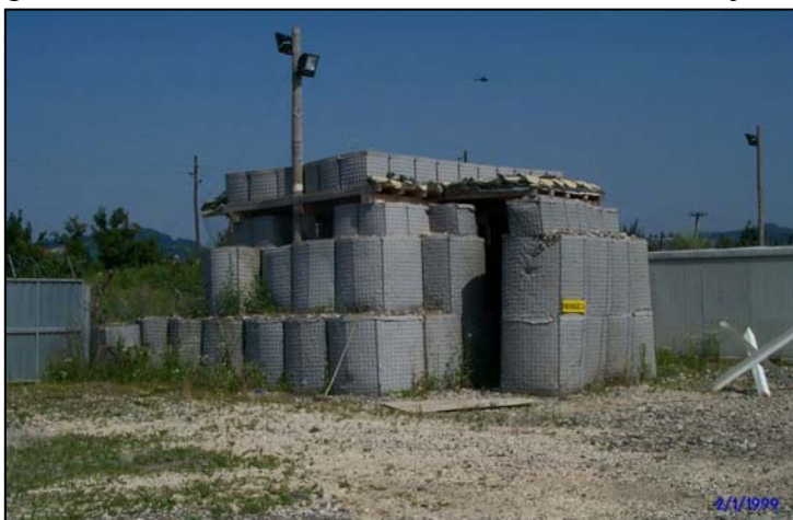
25. kép – HESCO elemekből épült fedezék
