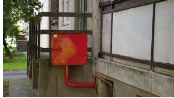
6. fénykép: Nem a tűzoltási felvonulási terület felől került kialakításra a száraz felszálló betáplálási helye (forrás: FKI)
