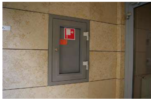
6. fénykép: Nem a tűzoltási felvonulási terület felől került kialakításra a száraz felszálló betáplálási helye (forrás: FKI)
