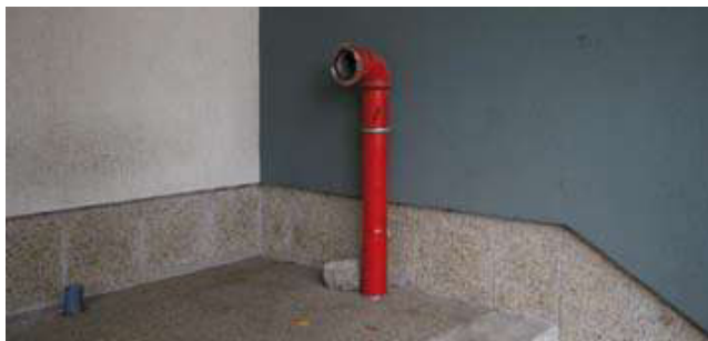
9. fénykép: Csatlakozási pont (forrás: FKI)
