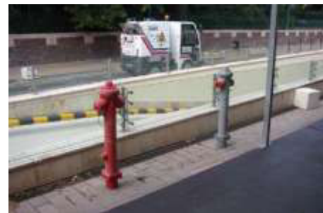
10. fénykép: Eltérő színben jelölve a tűzcsap és a száraz leszálló vezeték (forrás: FKI)
