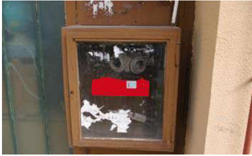
5.: A csatlakozó kapcsok, és a zárószerelvények is hiányoznak a betáplálási helyen (forrás: FKI)
